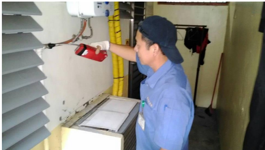
瓦斯公司定檢人員現場定檢狀況
